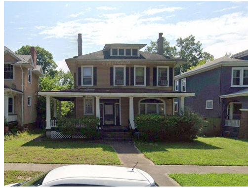
2805 Edgewood Ave - Porch
