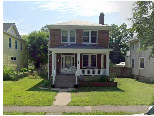
2815 Edgewood Ave - Porch
